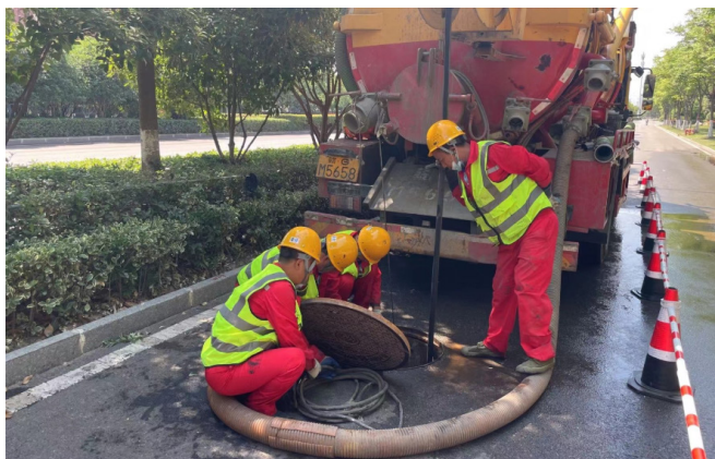
图1 无开挖修复技术
