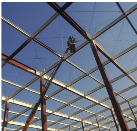
图1 防火涂料施工
