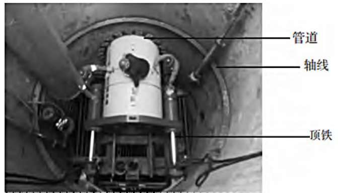
图1 顶铁及顶管标准节
