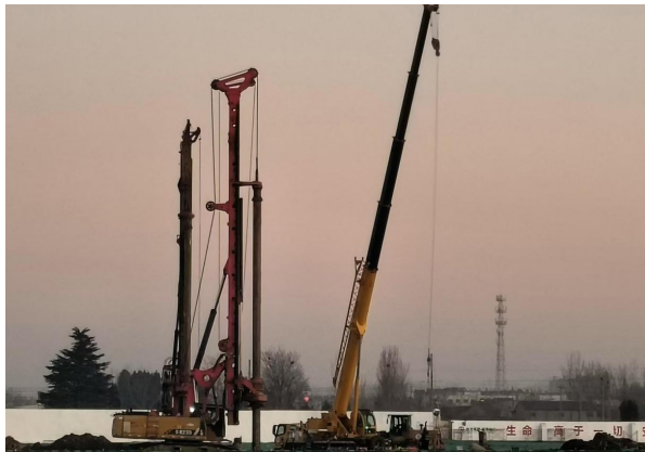
图1 旋挖钻孔灌注桩技术
