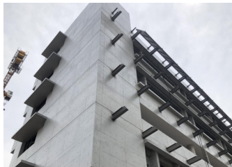
图 2 预埋件实施后布置图
