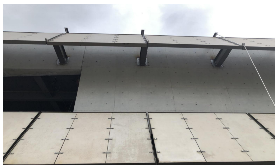
图 12 不锈钢拉杆连接
