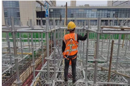
图2 脚手架检查
