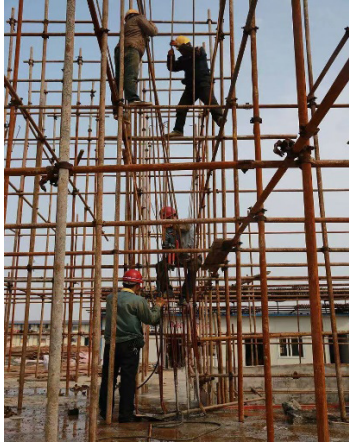
图1 脚手架搭设
