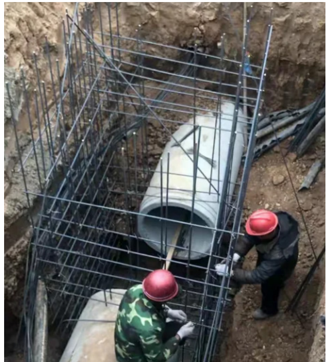
图2 检查井支模板与浇筑
