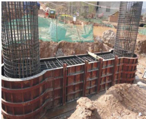
图1 梁钢筋骨架放入模板
