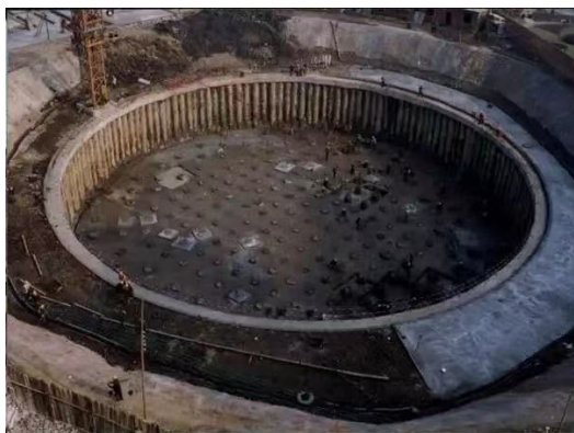
图 1 复杂工程基础施工
