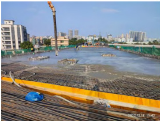
图2 大体积混凝土浇筑
