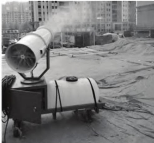
图1 施工现场除尘喷雾机
