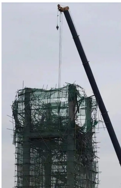
图2 脚手架倒塌
