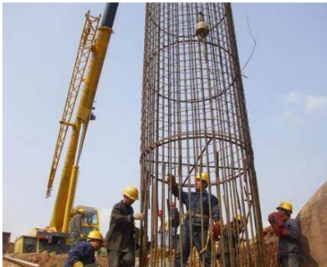
图1 钻孔灌注桩
