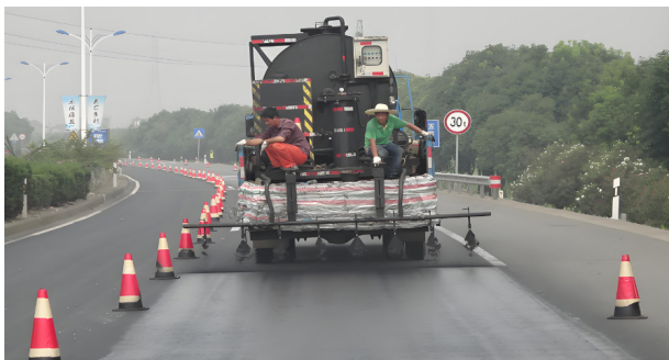
图2 路面封层处理
