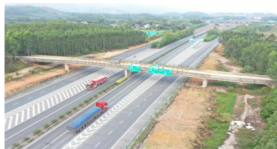
图 1 K3528+608 天桥现状图片
