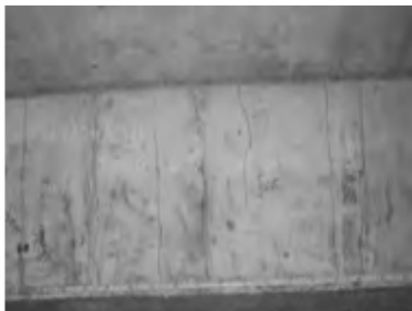
图2 荷载裂缝
