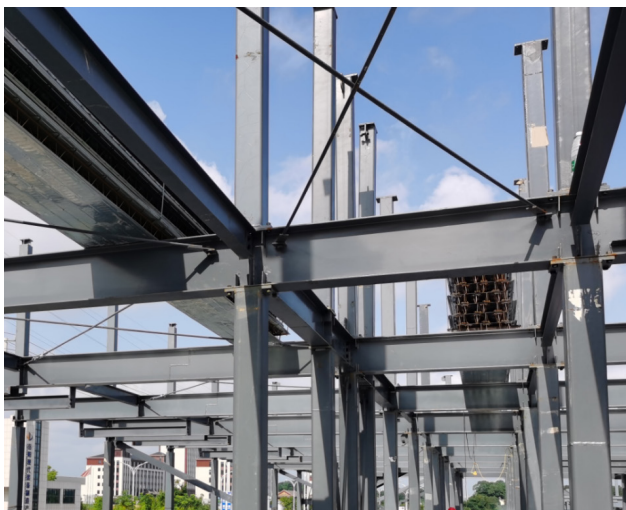
图1 装配式建筑钢结构
