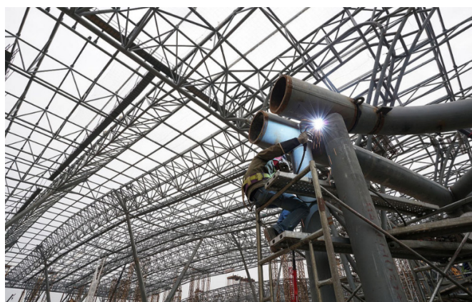
图 2 钢结构焊接现场
