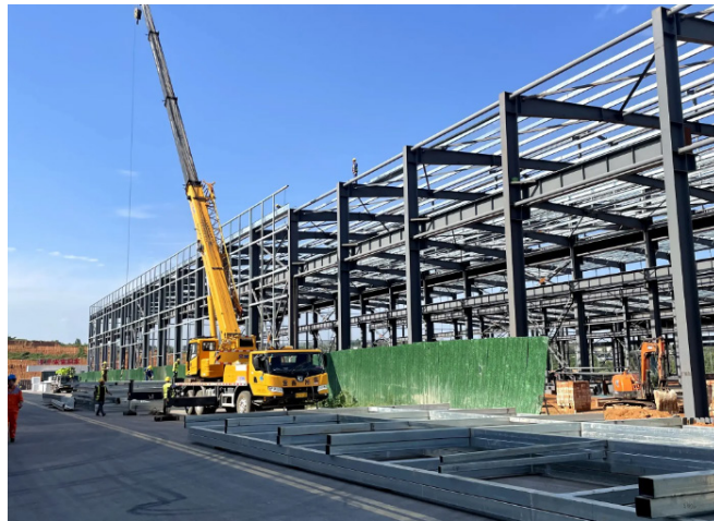
图1 钢结构吊装现场图
