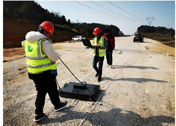
图1 地质雷达检测现场
