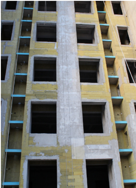
图1 建筑外墙保温工程施工
