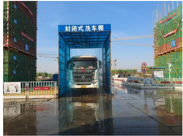
图1 采用全封闭冲洗车平台清洗运输车辆
