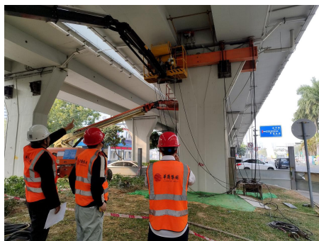
图9 钢牛腿法顶升施工实例
