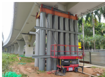
图3 钢支架顶升施工实例
