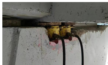
图4 薄型千斤顶顶升施工实例
