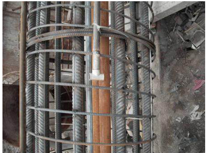
图2 钢筋笼与注浆管固定
