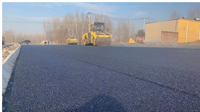
图 1 混凝土路面压实
