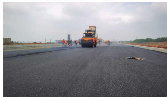
图 1 施工现场采用压路机进行沥青路面压实作业
