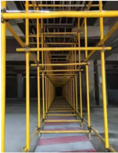
图1 模板独立支撑构造
