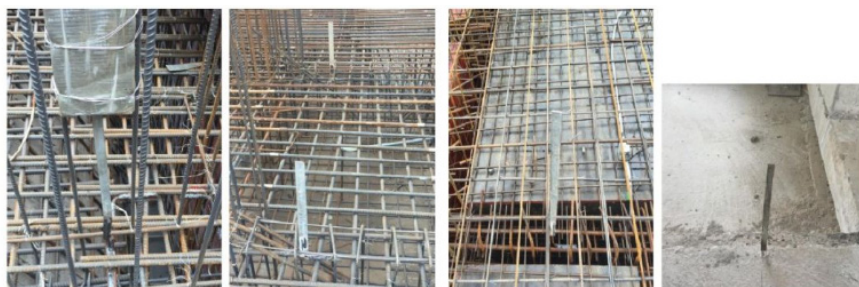
图1 防雷接地预埋件的布置
