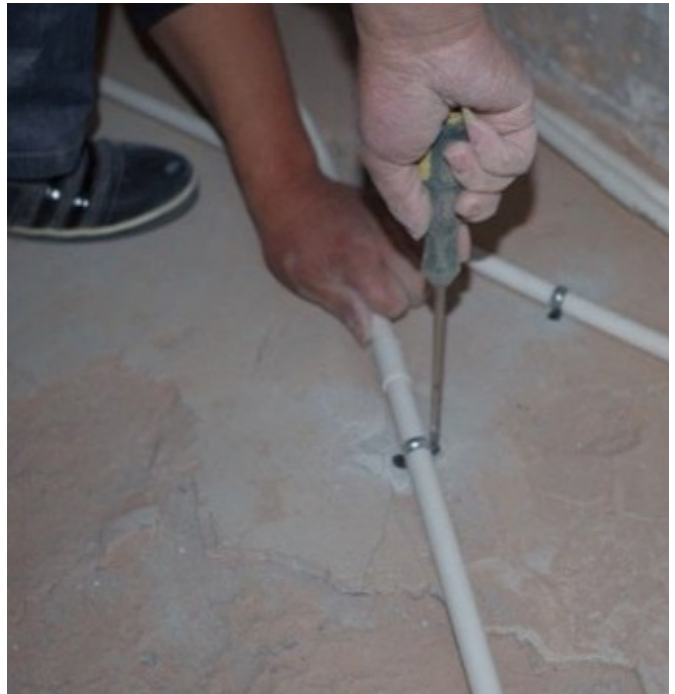
图2 管线固定方式
