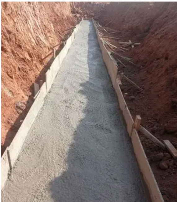
图2 管道基础施工
