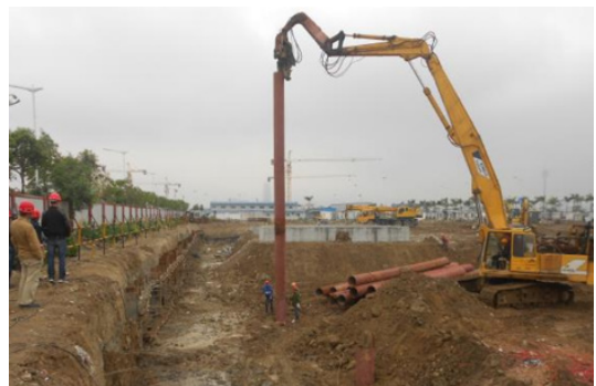
图2 采用钢便桥 转运平台解决深厚软土地区狭小空间
