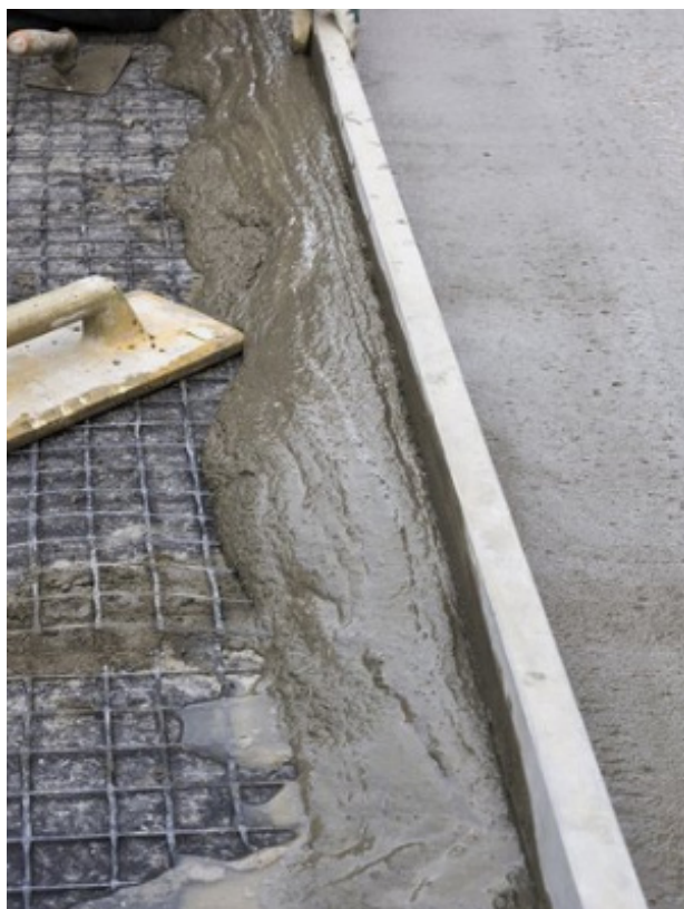
图为水电站混凝土施工
