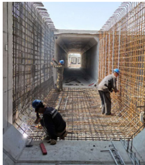
图1 综合管廊施工现场
