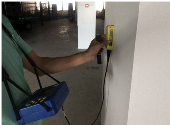
图1 钢筋锈蚀电位检测法
