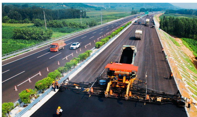
图1：公路沥青混凝土路面
