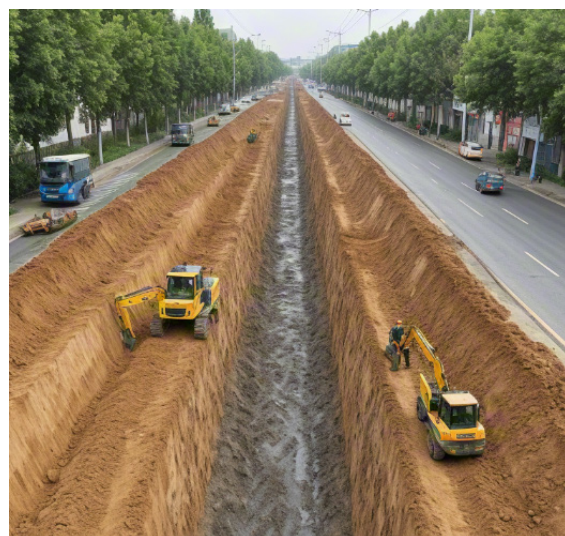
图1 沟槽开挖及边坡支护施工
