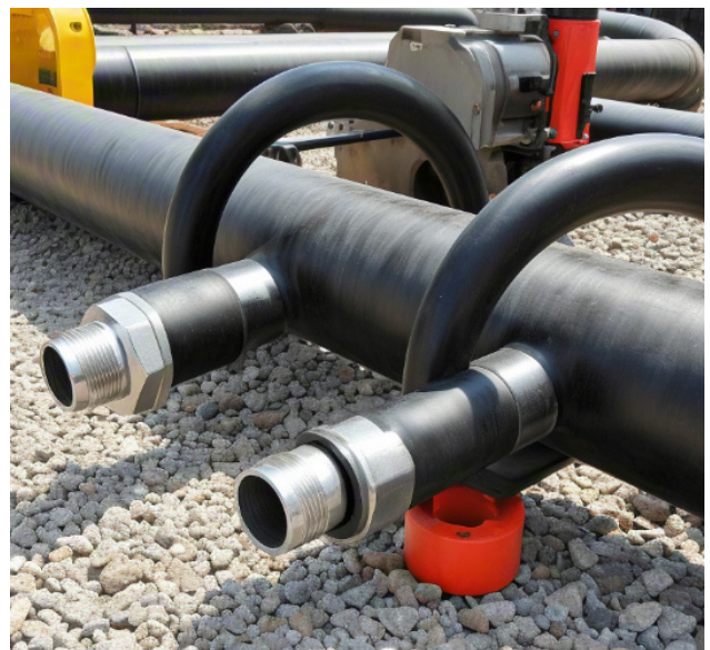
图2 管热熔连接施工
