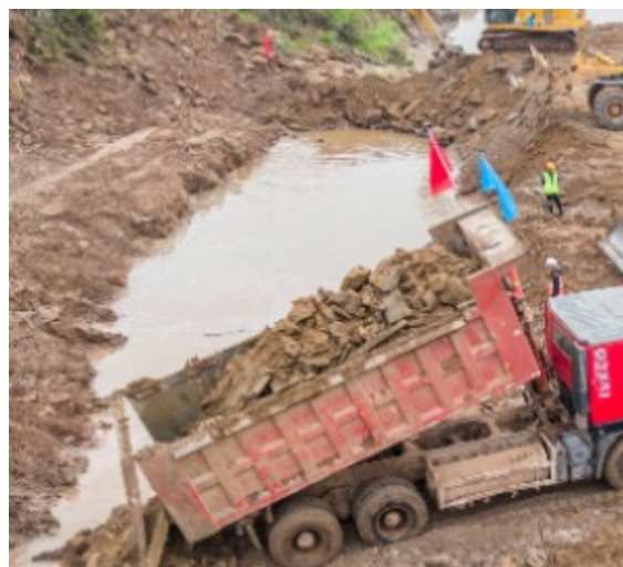
图2 截流施工现场
