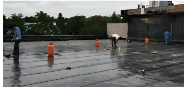
图2 屋面防水防渗施工
