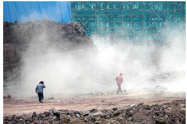
图1：施工扬尘污染
