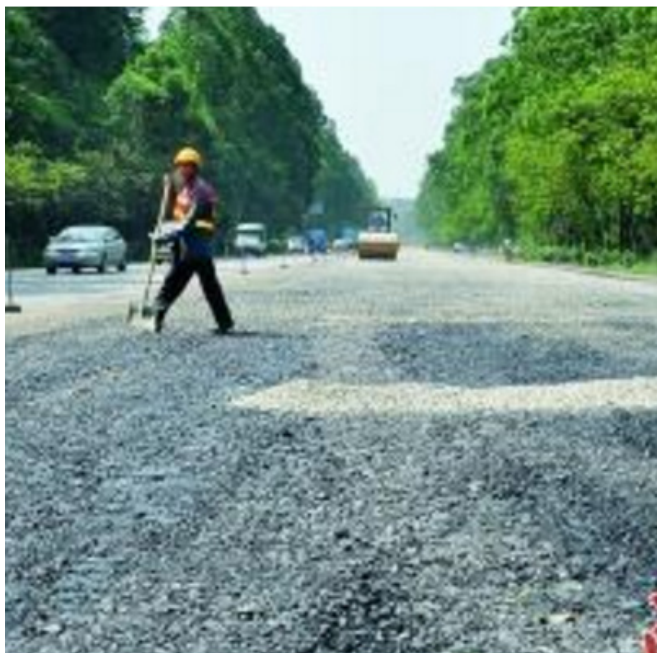
图1 路面垫层施工
