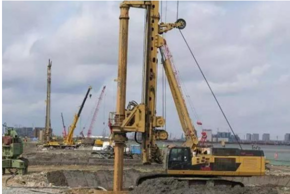
图1 旋挖钻机成孔
