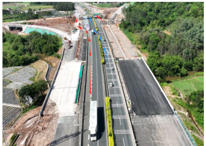
图 3 贯通车道 + 左幅保通，拆除第二跨
