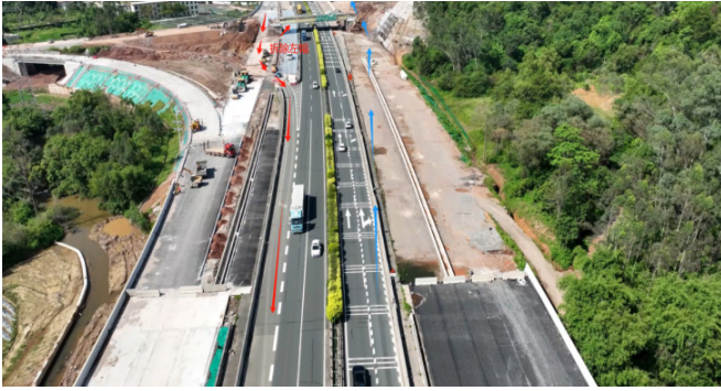
图4 贯通车道保通，拆除第一跨
