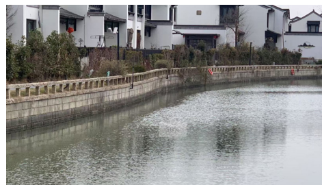
图五 装饰混凝土挡墙成型影像
