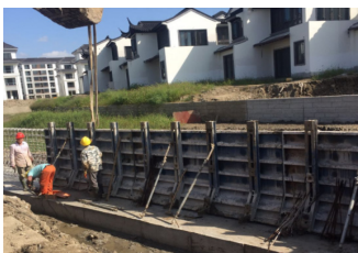
图三 造型模板固定安装
