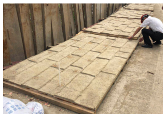
图四 造型模板拆除、养护
