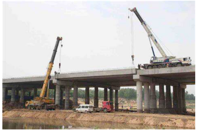
图1：大型机械作业现场安全管理体现市政路桥施工严谨性
