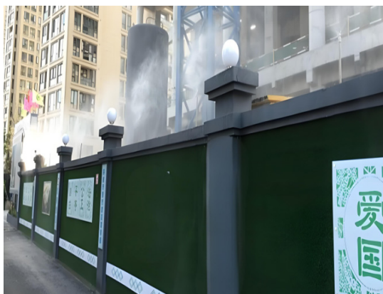
图1 施工现场的环保控制
