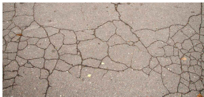
图1 路面裂缝
