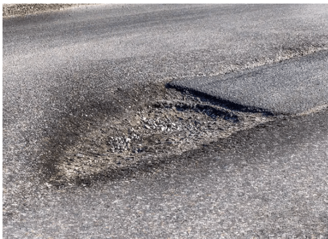
图 2 路面坑槽
