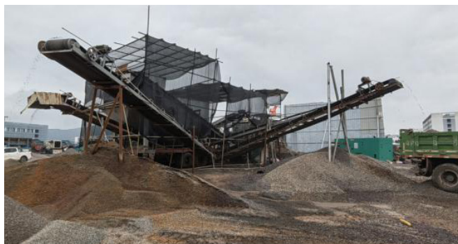
图2 再生骨料破碎现场图片
