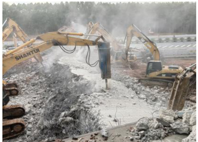
图 1 桥梁拆除现场图片
