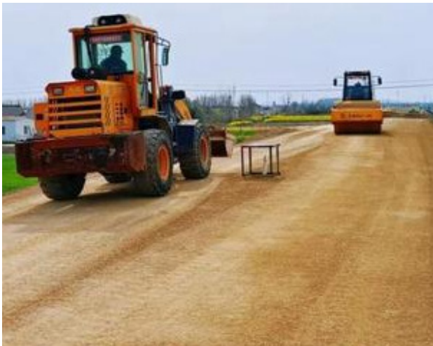
图1 碾压施工
