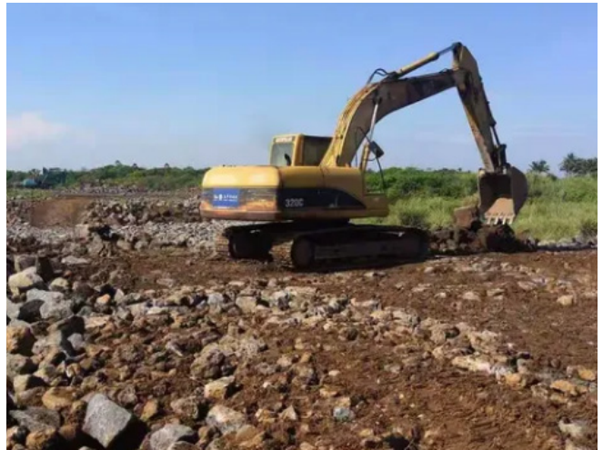
图2 石方填筑施工
