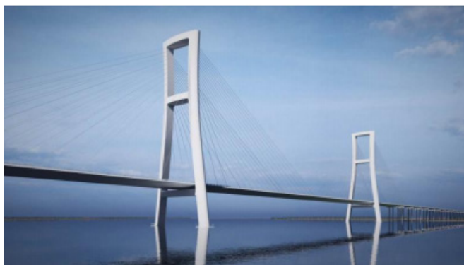
图1 安罗黄河特大桥主桥索塔造型示意
