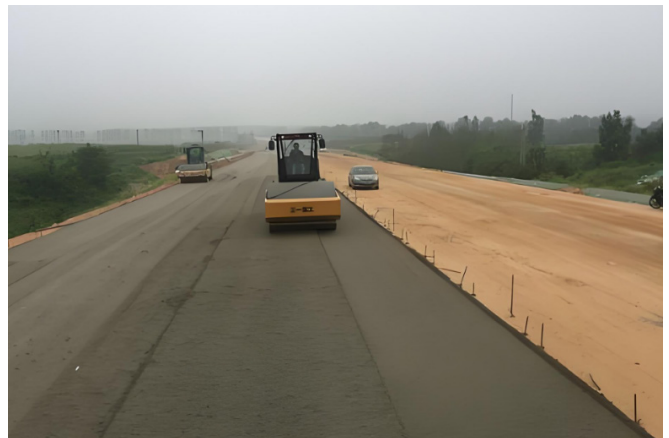
图2 水泥稳定碎石基层碾压施工现场
