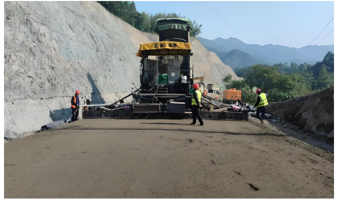
图1 水泥稳定碎石基层摊铺施工现场
