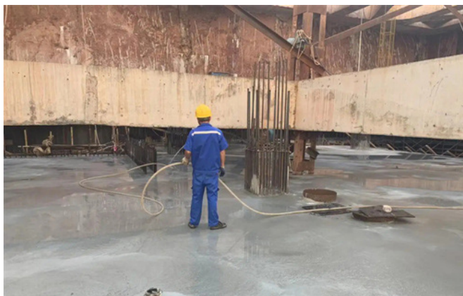
图一：混凝土浇水养护
