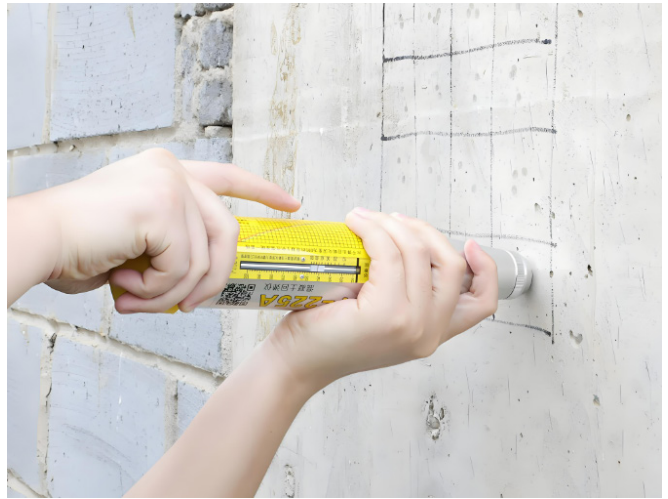
图 1 回弹仪在施工现场进行检测
